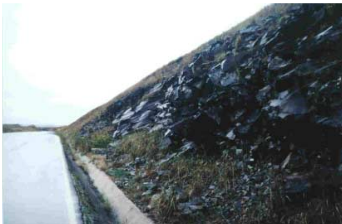
Figura 6 - Intensa disjunção horizontal com mergulho comum nas rochas vulcânicas ácidas do Tipo Palmas. BR-280 na proximidade de Palmas-PR.
