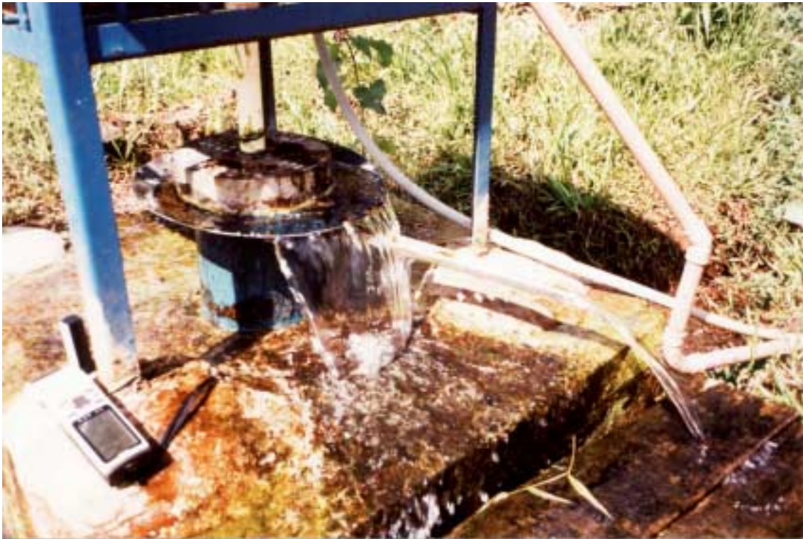
Figura 50 - Poço jorrante localizado na Linha Bela Vista – São Lourenço d'Oeste, com vazão livre de cerca de 4 m 3 /h (poço n°1875).
